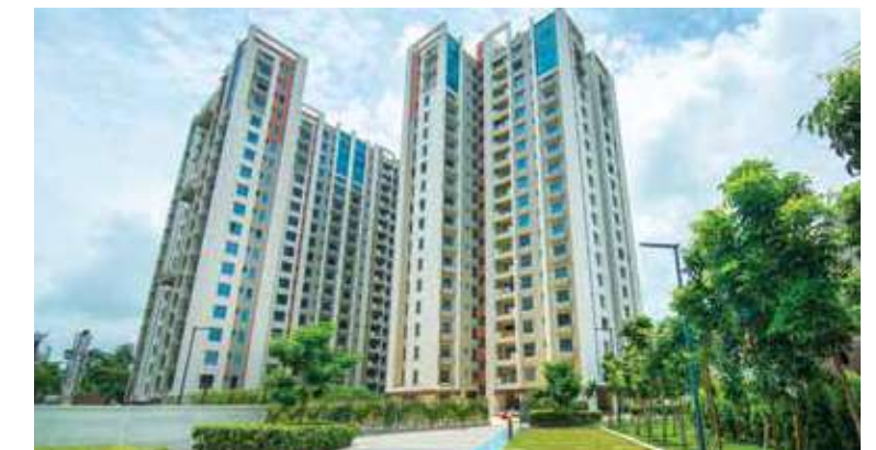
OZONE on South EM Bypass
